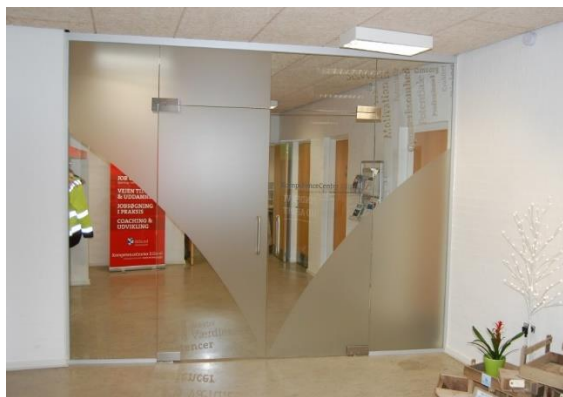
Glasdør med pinoler, dørlukker i gulvpinol.
