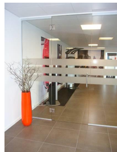
Glasdør uden karm med lukkefunktion i glashængsler.
